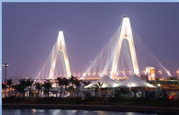
(海口世纪大桥)
